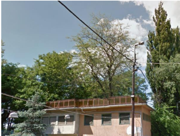
Légvezetékes kisméretű erőátviteli és közvilágítási hálózat
