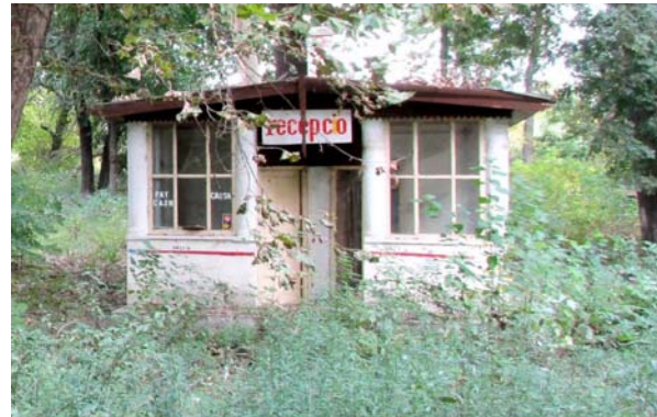
Egykori kemping fogadóépülete
