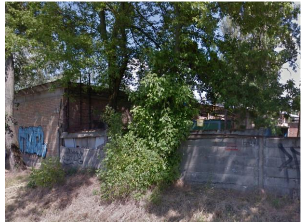
Népsziget úti gáznyomásszabályzó
